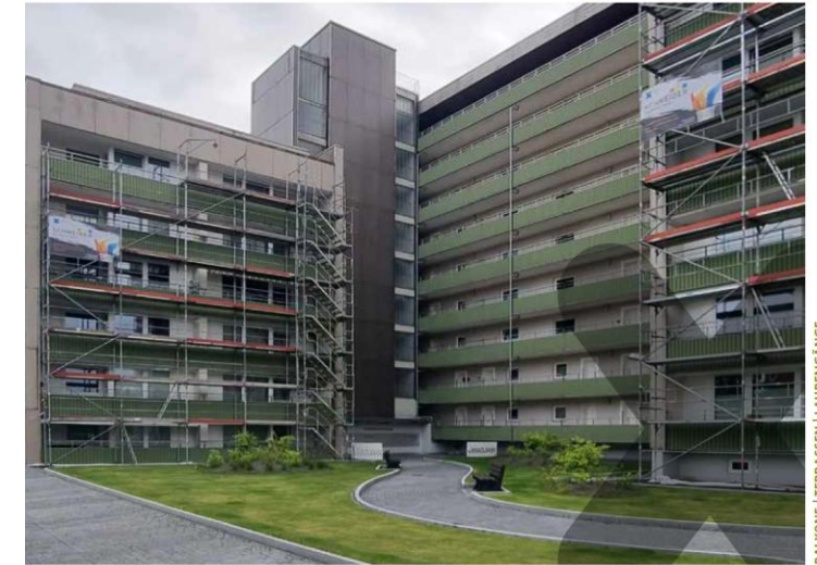
BALKONE | TERRASSEN | LAUBENGÄNGE
