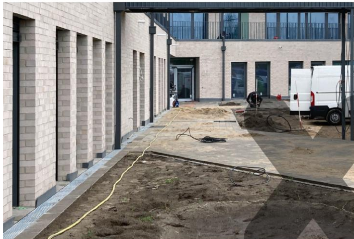
BALKONE | TERRASSEN | LAUBENGÄNGE
