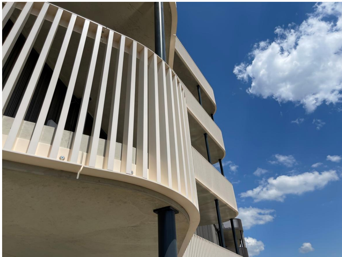
Foto: Aluminiumgeländer an geschwungene Form der Betonteile angepasst
