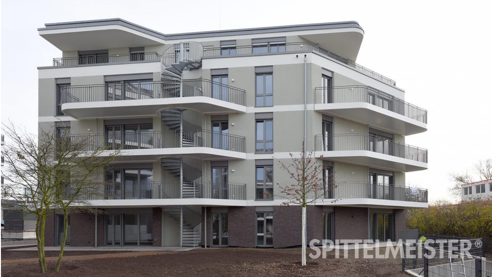
Fotos: 103 auskragende Stahlbalkone an Schöck ISO-Elemente montiert; filigranes Staketengeländer mit abgesetztem Handlauf
