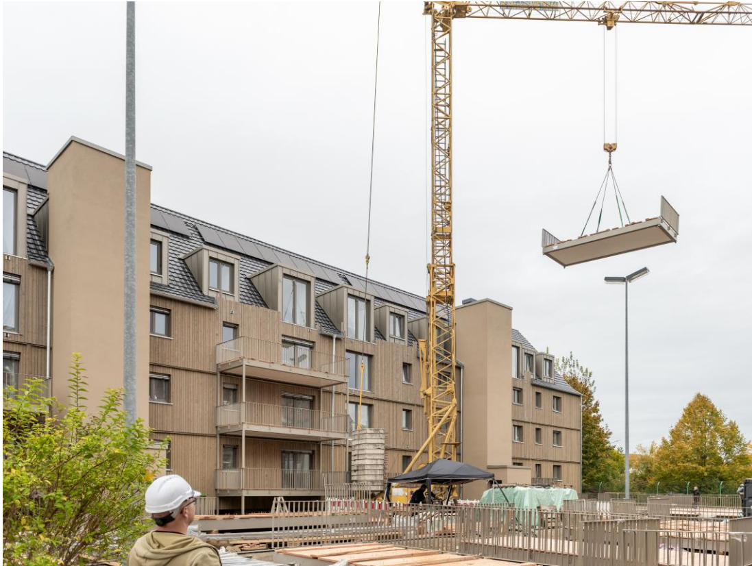
Foto: Stahl-Systembalkone mit Staketengeländer (verzinkt + pulverbeschichtet)
