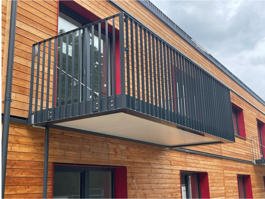
Foto: Aluminium-Systembalkon mit geschlossener Untersicht als wasserführende Ebene, geregelte Entwässerung über Rohrsystem, filigranes Flachstahlgeländer (verzinkt + pulverbeschichtet)
