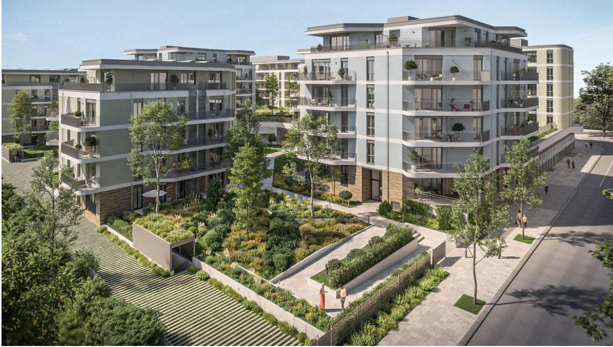
Fotos: 103 auskragende Stahlbalkone an Schöck ISO-Elemente montiert; filigranes Staketengeländer mit abgesetztem Handlauf
