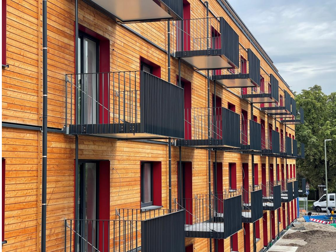
Fotos: abgehängte Aluminium-Systembalkone mit filigranem Flachstahlgeländer (verzinkt und pulverbeschichtet); Balkonbeläge: Betonwerksteinplatten 400X400X40 mm
