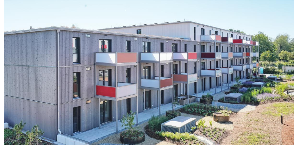
Fotos: vier gestützte Alu-Balkone mit Alu-Geländer und VSG-Glas mit teilweise farbigen Folien; Balkone barrierefrei begehbar
