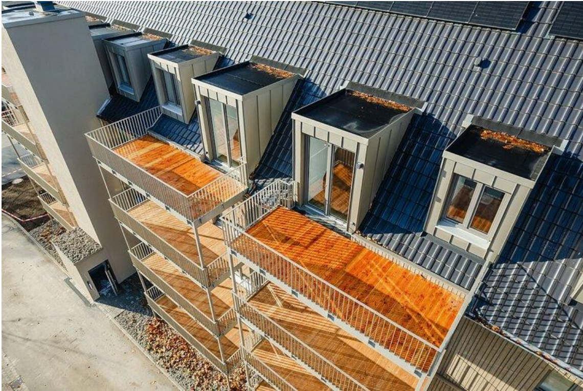
Foto: Stahlsystembalkone mit Staketengeländer (verzinkt + pulverbeschichtet)
