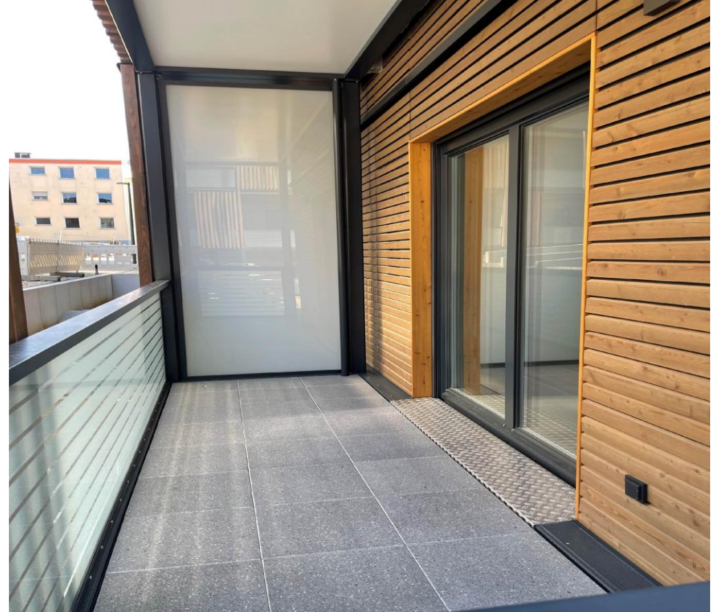
Foto: barrierefreier Übergang und Trennwände in VSG (mattweiße Folie)
