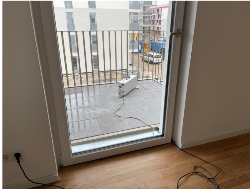
Foto: Trittschallmessungen vor Ort durch genormte Verfahren an Spittelmeister® System-Balkonen
