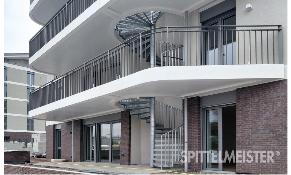
Fotos: auskragende Stahlbalkone mit feuerverzinkten Stahl-Fluchttreppen; Stahlrahmenprofile mit runden „Ecken“; Balkon-Profilhöhe folgt dem Fassadenstreifen
