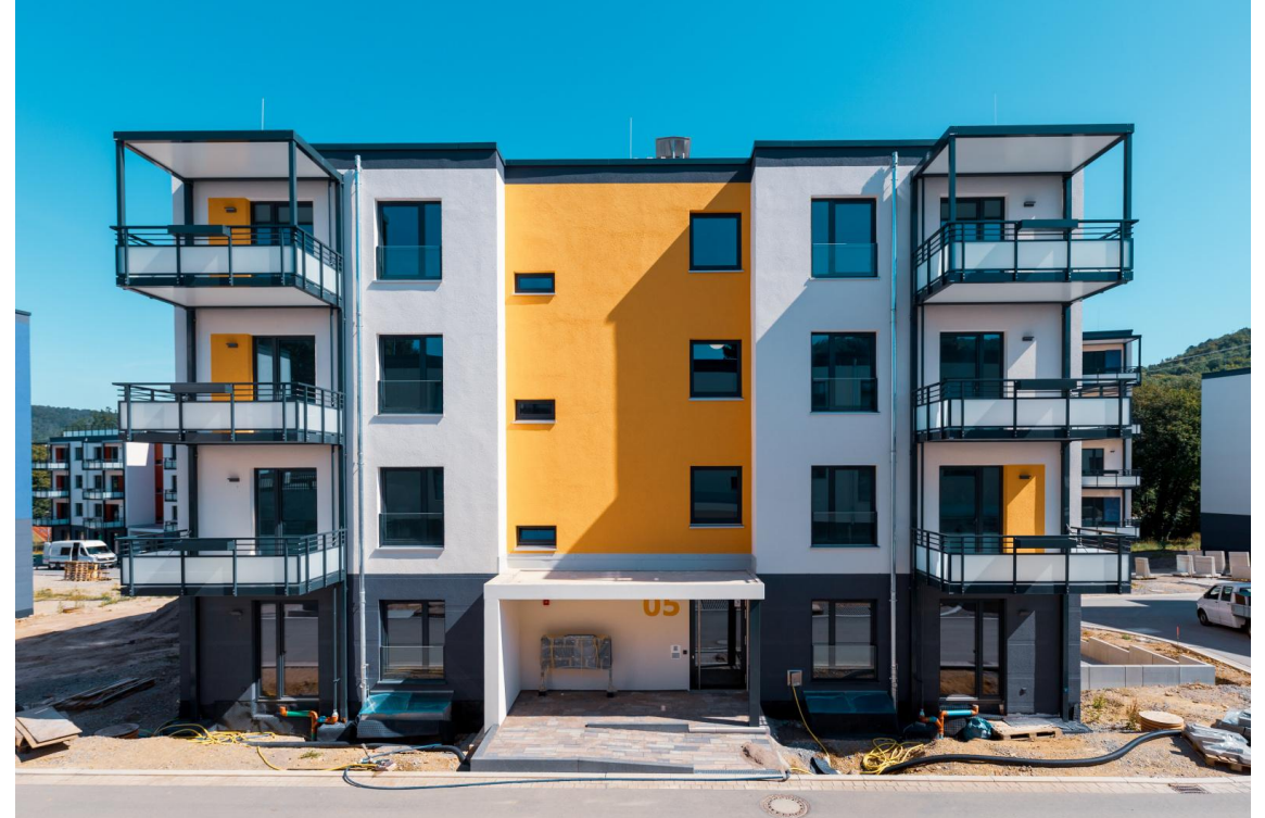
Fotos: abgehängte Aluminium-Systembalkone an Stahlisene vor der Fassade
