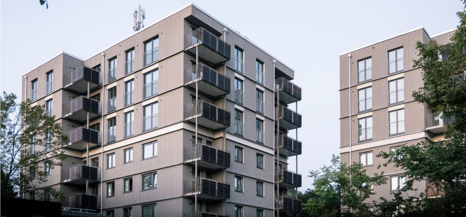
Fotos: gestützte Aluminium-Balkone mit PV-Modulen an den Geländern
