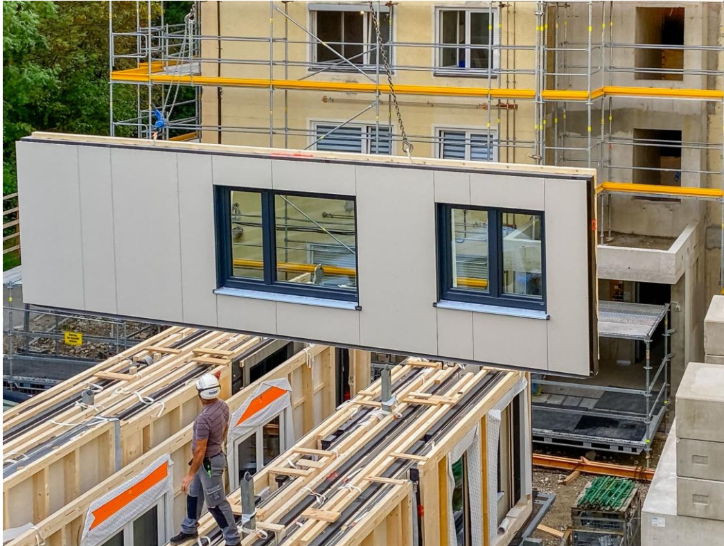
Foto: Einbau der Holz-Fassadenmodule
