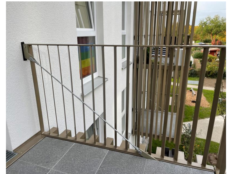
Fotos: Schrägzug-Abhängung und barrierefreier Übergang
