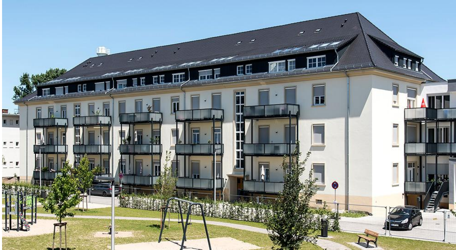
Fotos: vier gestützte Alu-Balkone mit Flachstahl-/Staketengeländer und mattweißem Glas als Sichtschutz
