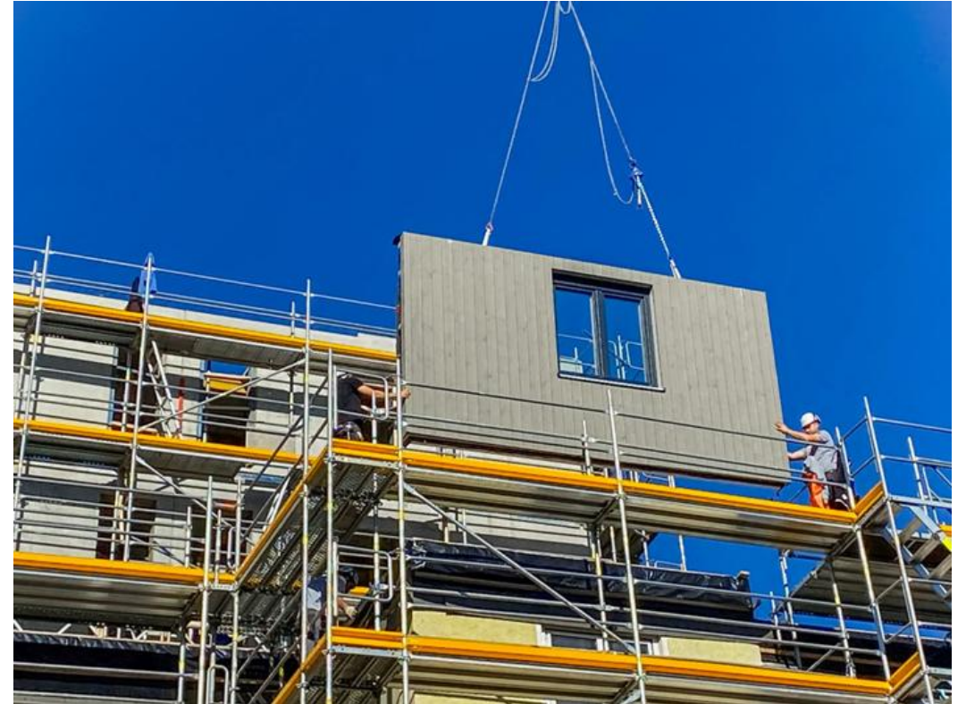
Foto: Einbau der Holz-Fassadenmodule
