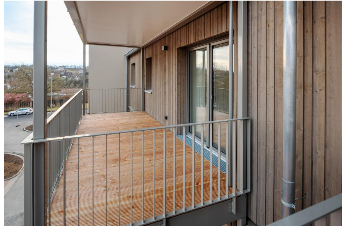
Foto: Holzbeläge und barrierefreier Übergang (Gitterrost vor der Balkontür)
