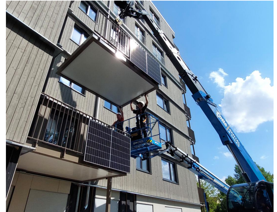
Fotos: Montage der Aluminium-Balkone
