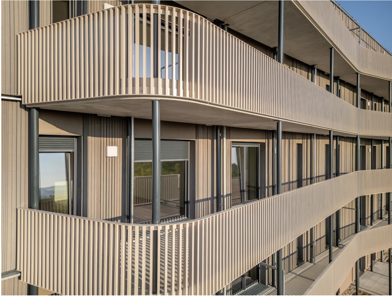
Foto: Geländer in Aluminium angepasst an die geschwungene Form der Betonfertigteile
