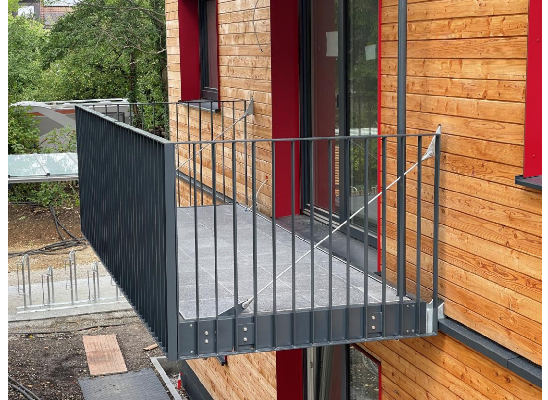
Fotos: Schrägzugabhängung an Holzlisene in der Holzfassade
