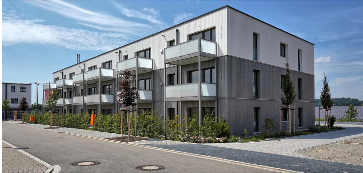
Fotos: vier gestützte Alu-Balkone mit Alu-Geländer und VSG-Glas mit mattweißen Folien; Balkone barrierefrei begehbar
