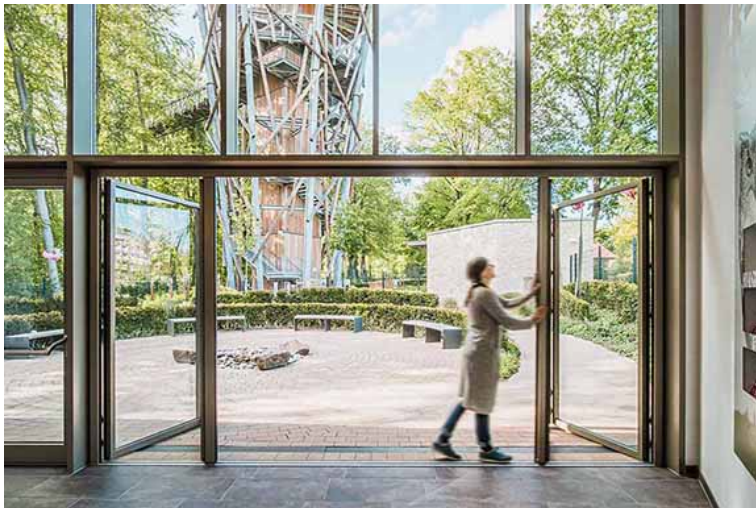
solarlux-sl70e-ref01671-9266: Großzügige Glasfronten von zwei Metern fünfzig Höhe und vier Meter achtzig Breite öffnen den Pavillon zum Baumwipfelpfad.
