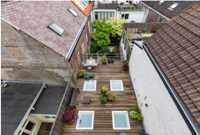
Solarlux_GFW_ref01595-mv29: Über dem Küchenbereich liegt die Terrasse. Vom Dachgeschoss aus gesehen wird nochmal deutlich, wie schmal das Haus ist. (Bild: Martijn Vonck)
