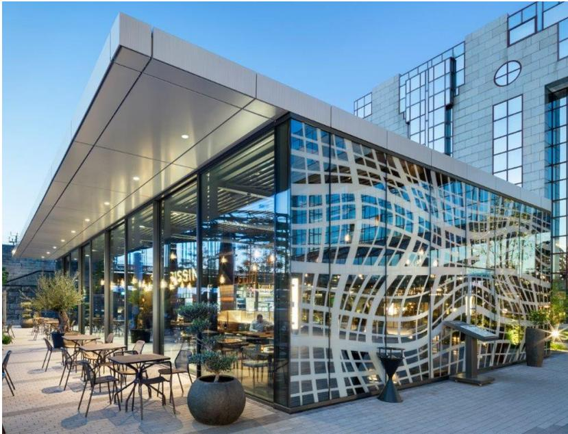
**Solarlux-cero-ref01585-054:** Gelungenes Gesamtbild: Die Schiebefenster gehen nahtlos in die Pfosten-Riegel-Fassade über. So durchläuft die Glasfassade harmonisch alle vier Seiten.
